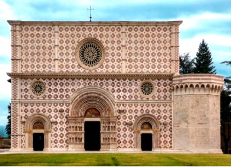
Figure 23. Basilica of Collemaggio
